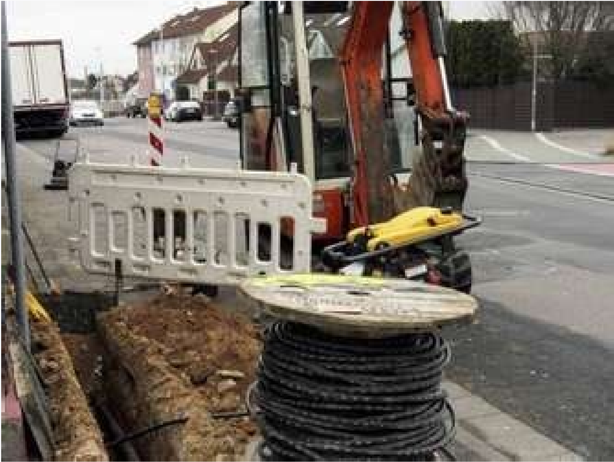
Glasfaserkabel unter straÙe verlegen. Glasfaserkabel verlegen straÙe kosten.
